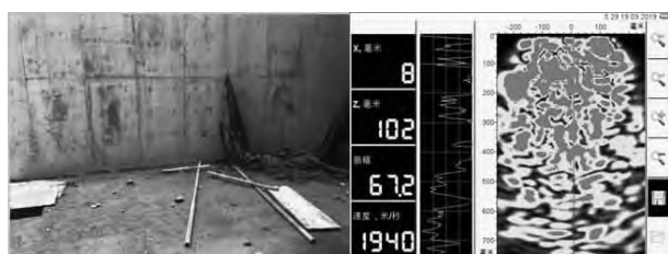
图5 现场勘察情况
